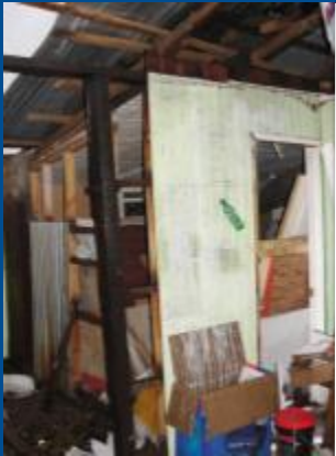
Viviendas para reparación
